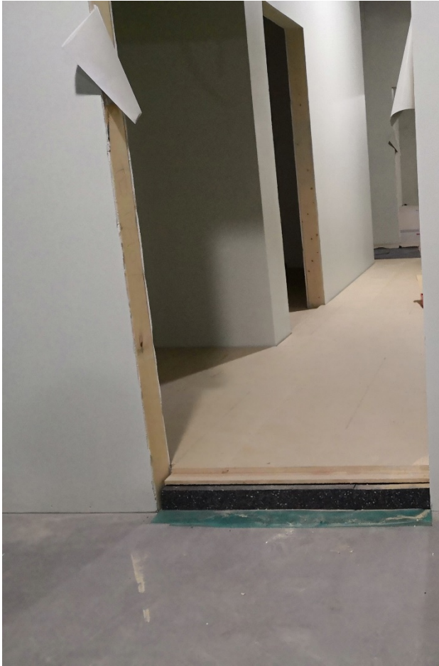
Bild 3 - Uppbyggnad av golv i slöjd
